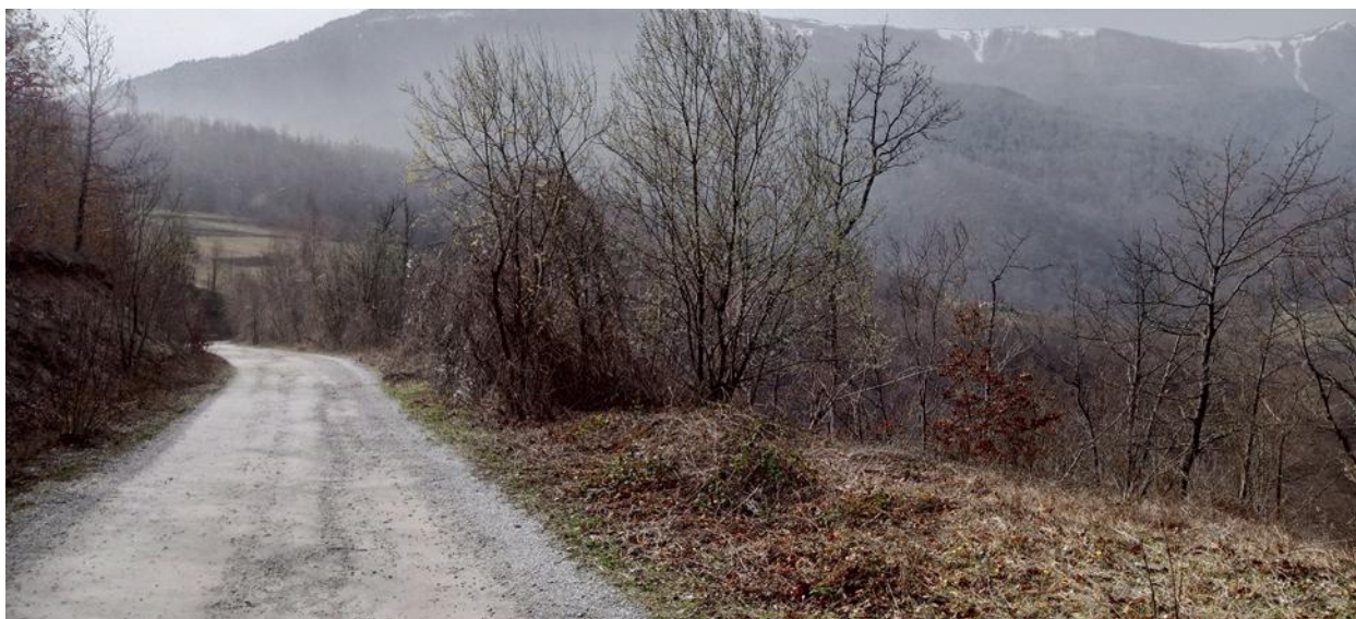
Slika 3: Trenutno stanje predmetne lokacije
