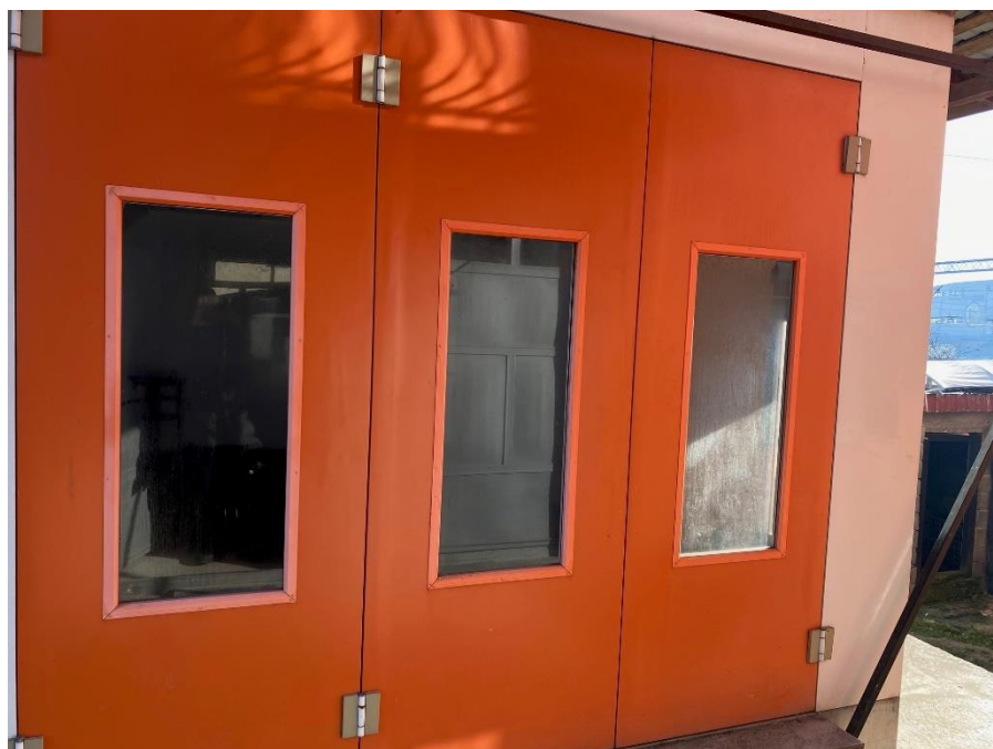
Slika 5. Izgled predmetnog objekta, decembar 2025. godine
