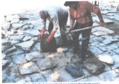
Foto 31. Početni radovi na rekonstrukciji poda
