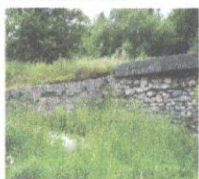
Slika 4: Detalj zidnog parapeta na glavnoj saobraćajnici, u blizini jezika
