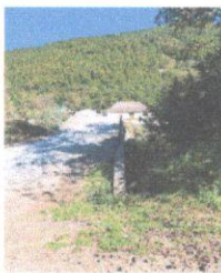
Slika 3: Detalj zidnog parapeta na glavnoj saobraćajnici, u blizini jezika
