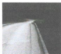
Slika 5: Detalj zidnog parapeta na glavnoj saobraćajnici, u blizini jezika
