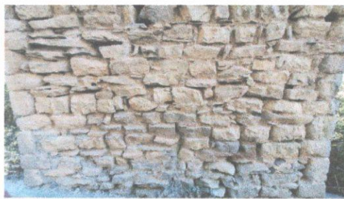
Slika 13 – Detalj sloja kamena na svodu
