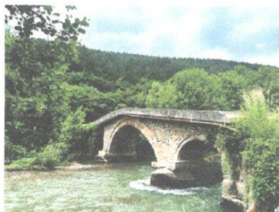
Slika 9 – Pogled na most sa uzvodne strane, odmah iza objekta
