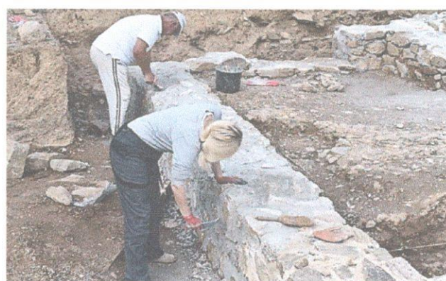
Uklanjanje viška maltera sa ulivenih fuga
